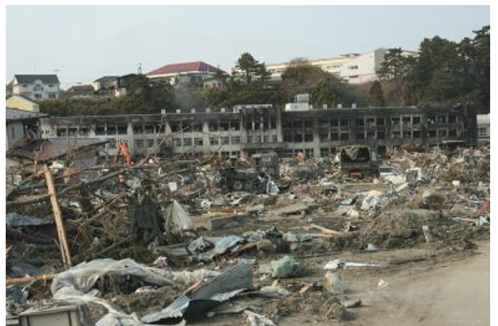
石巻市内小学校は津波と火災の大打撃を受けた
